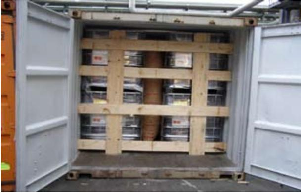
Die nächsten 8 IBC werden in den Container geladen. Im Türbereich erfolgt eine rückwärtige Sicherung aus vier waagerechten und zwei senkrechten Dielen. Der geringe Freiraum im Türbereich wirkt sich unkritisch auf die Verschiebung des Lastschwerpunktes aus, der innerhalb der Toleranz bleibt.
